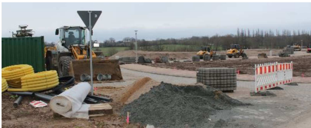
Noch viel Arbeit dort, wo die Ferienhäuser stehen werden
